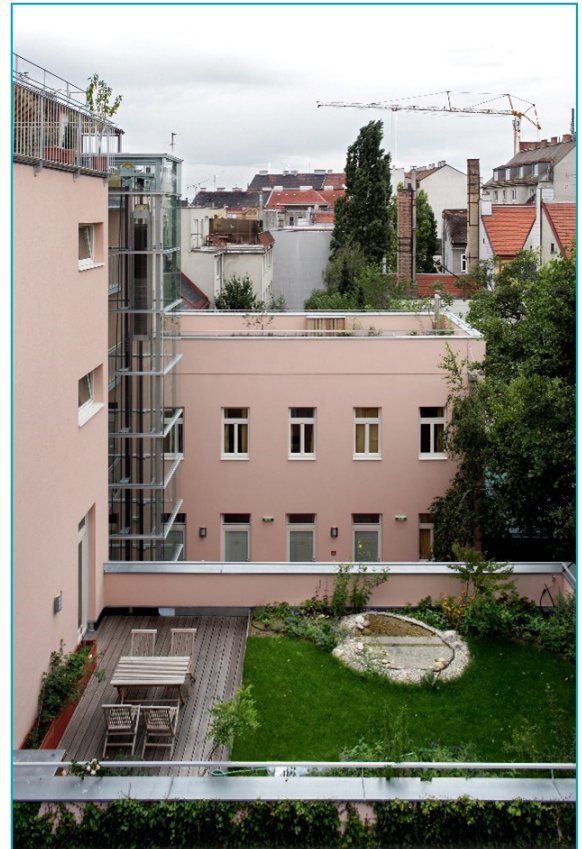
Terrassenbegrünung, Renovationsarbeiten © Manfred Seidl
